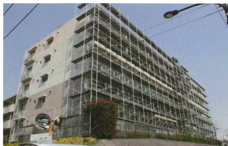
マンション改修
